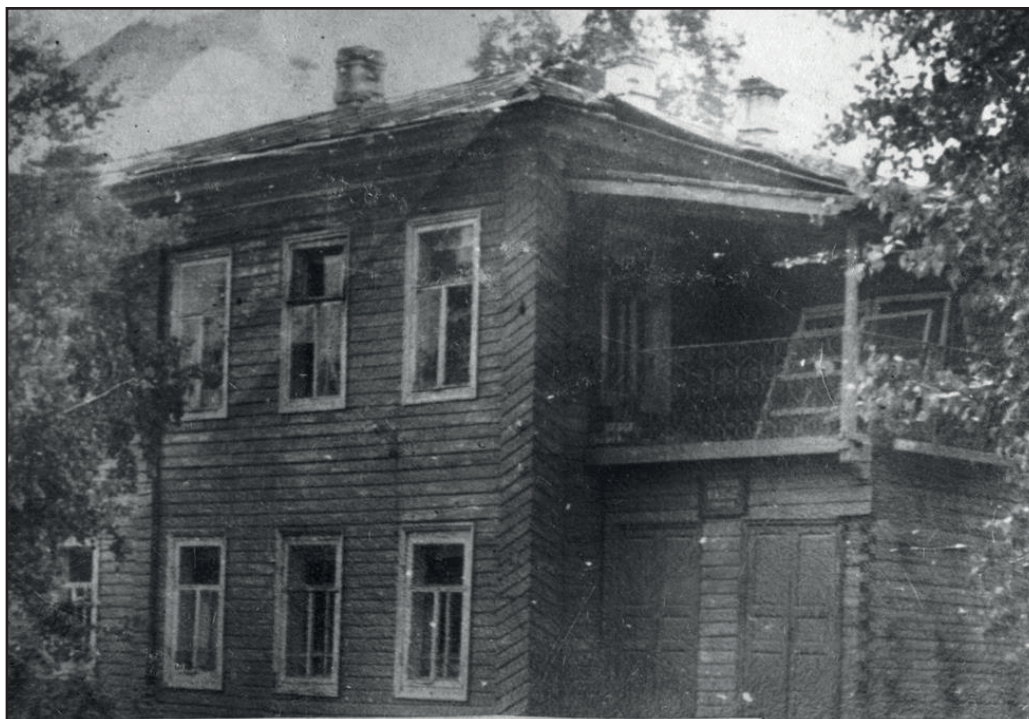
Здание «Центрального» детского сада г. Сыктывкара. 1960-е гг. (Архив Музея дошкольного образования ГПОУ «СГПК»)
